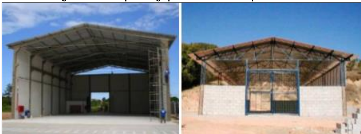
Figura 4.8 – Exemplos de galpões com estruturas pré-fabricadas.
