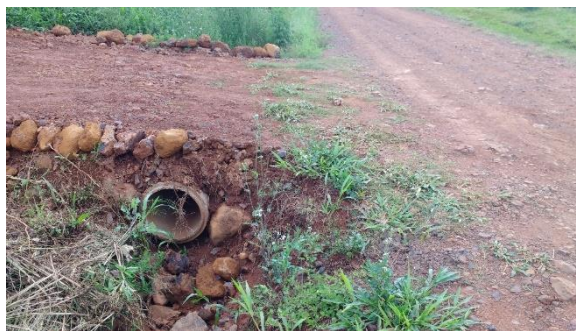
Figura 46: Lançamento de águas pluviais em valetas próximas às ruas
