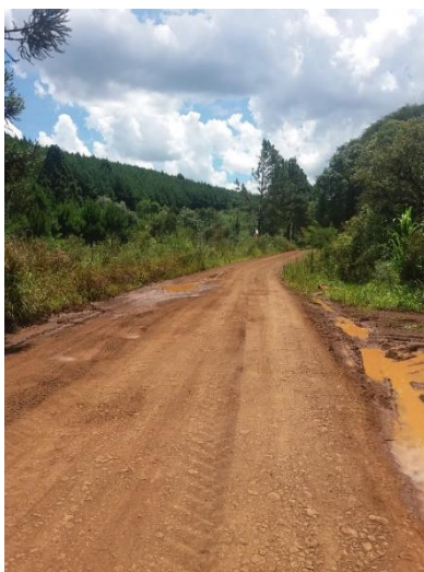
Figura 53: Ponto de alagamento 1 – localidade Brey Fonte: SOMMA (2017)
