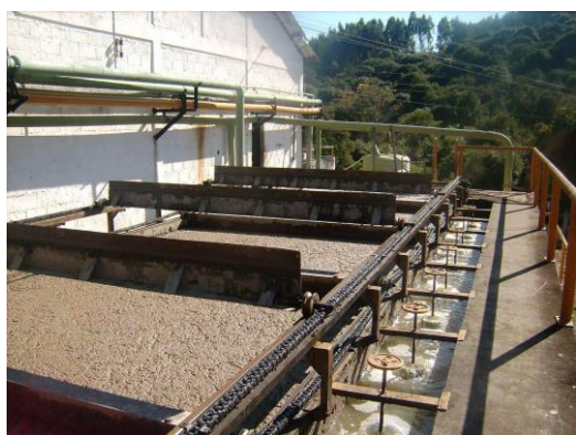
Figura 43: Tratamento de efluentes Piquiri Papéis (Flotador à esquerda e Peneira Side-Hill à direita)
