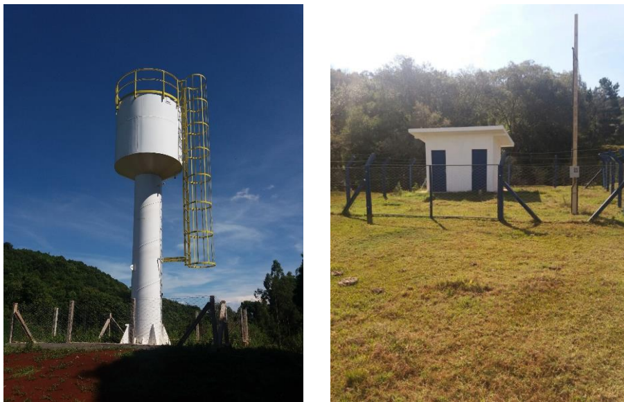
Figura 28: Reservatório e poço na comunidade Boa Vista
