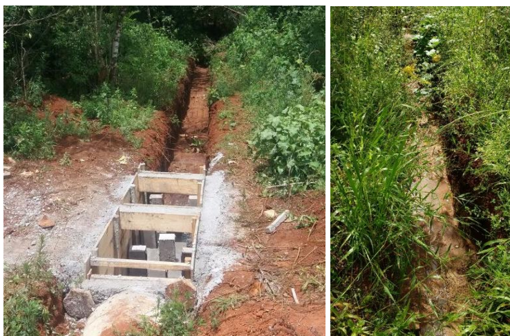
Figura 45: Dissipador na Rua Antônio Kramer e lançamento no rio Estacha
