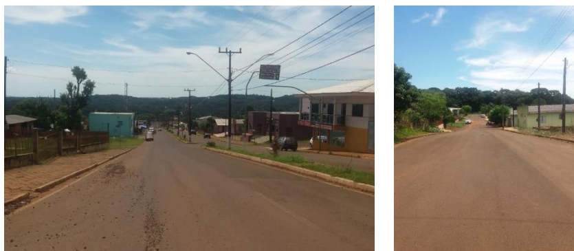
Figura 51: Vias asfaltadas com meio-fio (Av. João Ferreira Neves à esquerda e Rua Josemar Antônio Camilo à direita)
