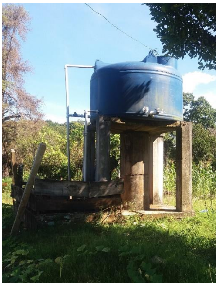
Figura 25: Reservatório comunidade Bahia
