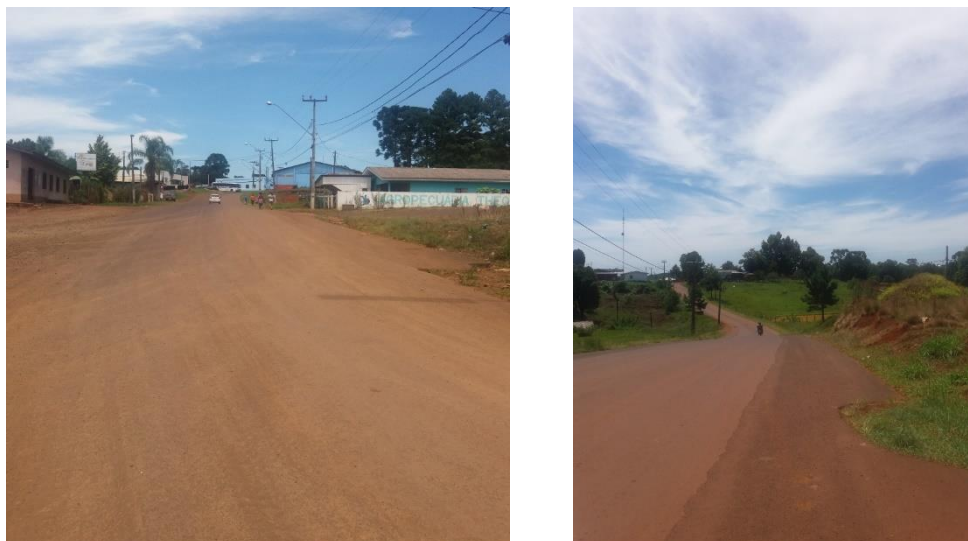
Figura 50: Vias asfaltadas e sem meio-fio (Av. José Pedro Seleme à esquerda e Rua Eng. João Cláudio Silvestre à direita)
