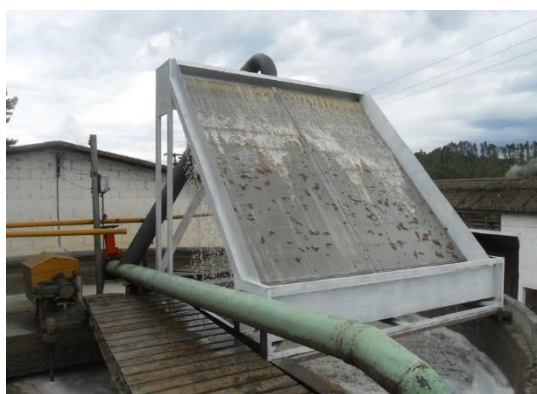
Figura 43: Tratamento de efluentes Piquiri Papéis (Flotador à esquerda e Peneira Side-Hill à direita)
