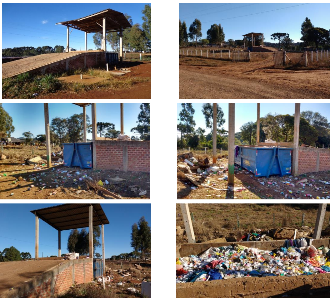
Figura 63: Estação de transbordo
